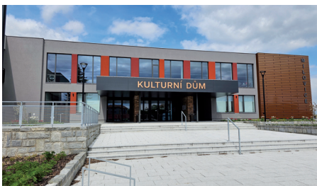
Rekonstruovaný kulturní dům v Milovicích
