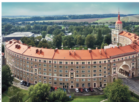
Ostravský městský obvod Poruba se zasadil o rekonstrukci souboru bytových domů OBLOUK , kulturní památky, která je svým vzhledem a půdorysem naprosto jedinečná na celém území Ostravy
