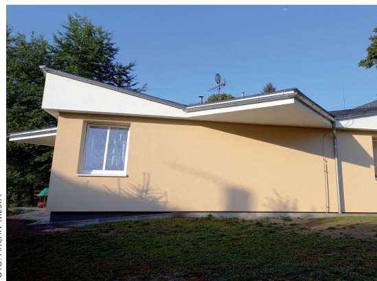
Rekonstruované bydlení pro seniory má název Penzion Hvězda
