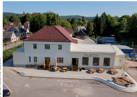
Lidový dům v Zaječově prošel zdařilou rekonstrukcí
