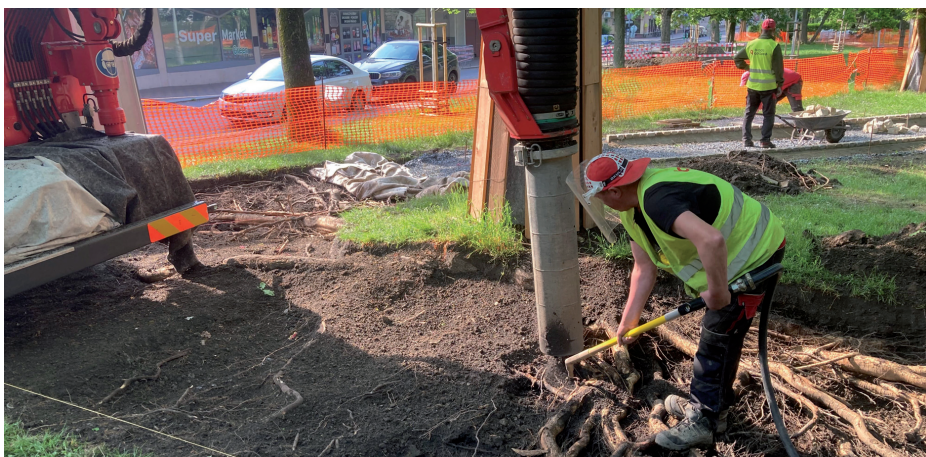
Pro odkrytí kořenů stromů byla použita technologie tlakového vzduchu AirSpade v kombinaci se sacím bagrem
