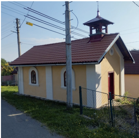
Zvonička v Lašovicích dostala při své rekonstrukci i nový nátěr v původních barvách
