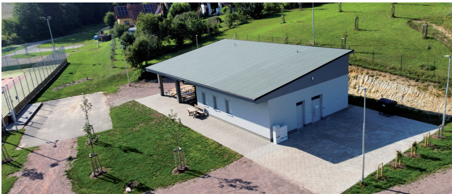
Komunitní dům je nízkoenergetickou stavbou a byl vybaven vzduchotechnickými jednotkami s rekuperací. Nezapomnělo se ani na jímání a využívání dešťové vody
