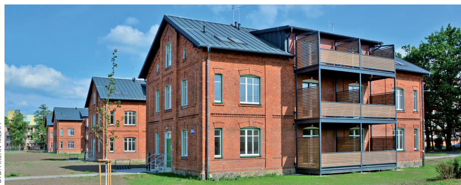
Červená kolonie získala svůj název podle domů z ostře pálených neomítaných červených cihel. Stavby z režného zdiva jsou však typické i pro další lokality Bohumína
