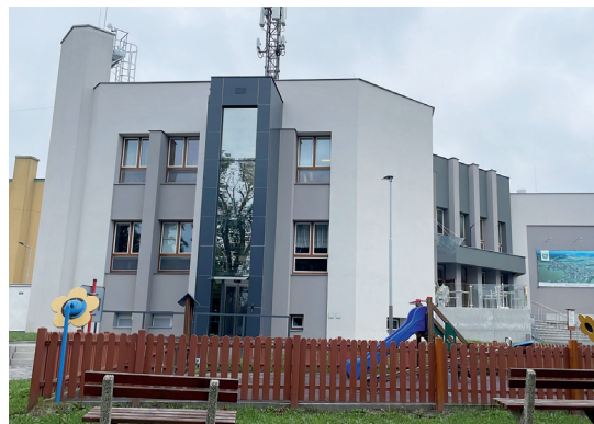
V srpnu 2023 začal v Mořkově fungovat výtah, který radnice nechala přistavět ke Společenskému domu, v jehož druhém patře se nachází obecní úřad
