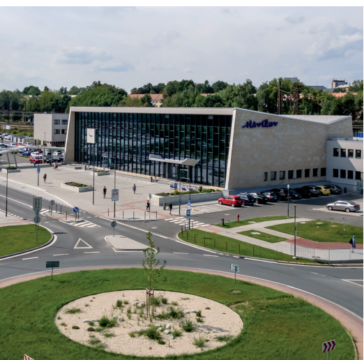
Sportovní hala Fénix v Havířově si ponechala původní vnější vzhled bývalé výpravní nádražní budovy v duchu tzv. bruselského stylu. Uvnitř je však proti minulosti k nepoznání
